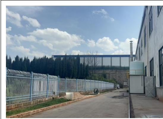
3#厂房南侧外部
