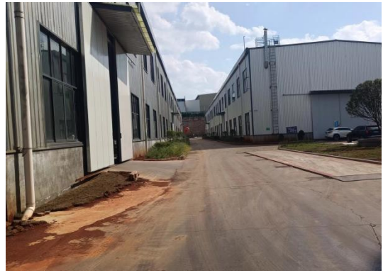
3#厂房北侧外部
